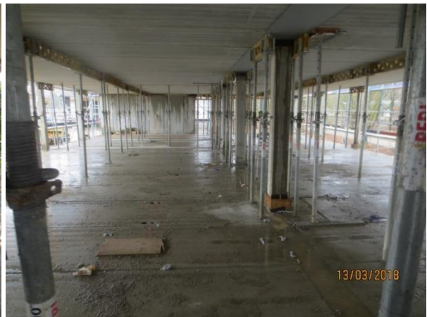
Abbildung 69: Baustelle BO - Abstützung der Spannbeton-Hohlplattendecke, [ACMS Architekten GmbH], 02.05.2018
