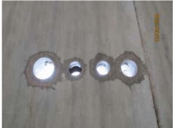
Abbildung 71: Baustelle BO - mangelhafter Betonverguss, [ACMS Architekten GmbH], 20.04.2018
