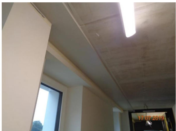
Abbildung 82: Baustelle BO - Deckenansicht verkleideter Verbundträger, [ACMS Architekten GmbH], 17.07.2019
