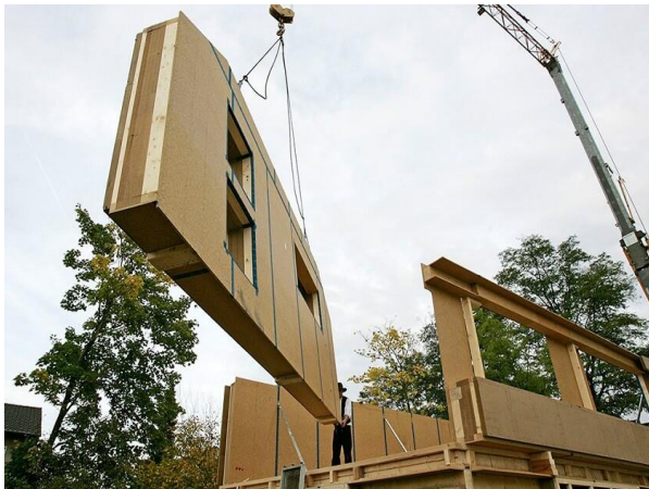
Abbildung 130: Holzrahmen- und Holztafelbau, [Holz vom Fach]
