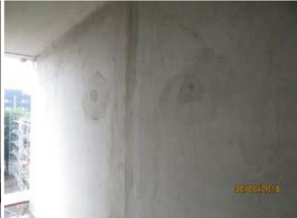
Abbildung 97: Baustelle BO - sichtbare Ausbesserungen, [ACMS Architekten GmbH], 28.05.2018
