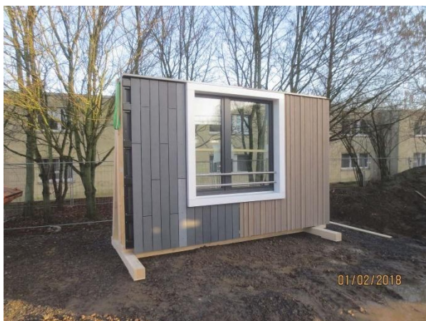
Abbildung 157: Baustelle BO - Musterfassade, [ACMS Architekten GmbH], 01.02.2018
