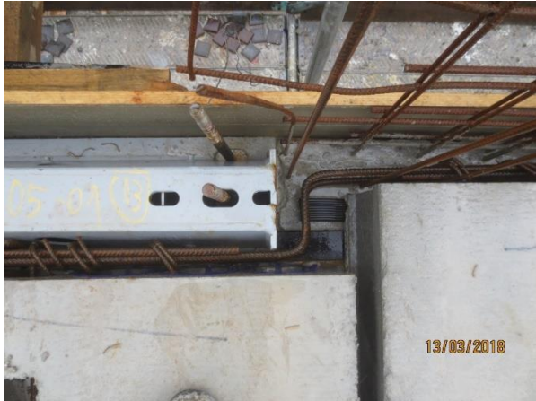
Abbildung 68: Baustelle BO - Anschlussbewehrung zum Stahlverbundträger bzw. Ringbalken, [ACMS Architekten GmbH], 13.03.2018
