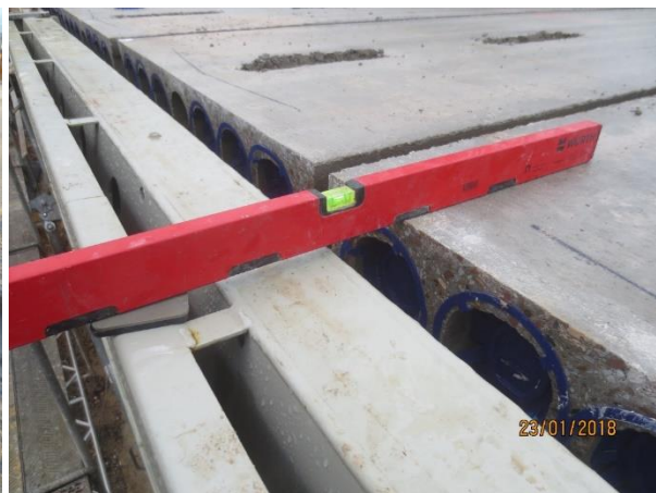
Abbildung 55: Baustelle BO - Ausführung des Anschlusspunktes Stahlverbundträger (Peikko) als Randträger und Spannbeton-Hohlplattendecke, [ACMS Architekten GmbH], 23.01.2018
