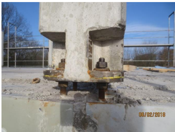
Abbildung 105: Baustelle BO - Stützenanschluss, [ACMS Architekten GmbH], 06.02.2018
