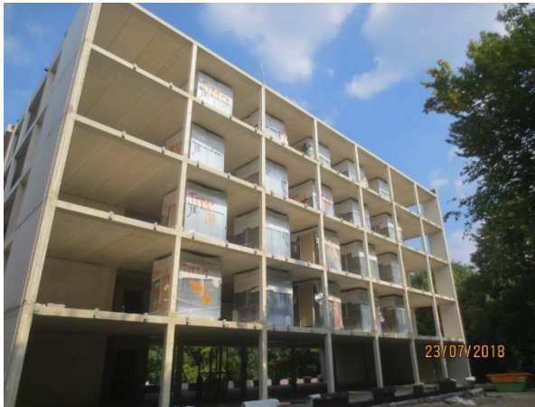
Abbildung 119: Baustelle BO - Fertignasszellen vorpositioniert, [ACMS Architekten GmbH], 23.07.2018
