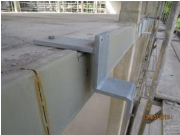
Abbildung 162: Baustelle BO - Winkel zur Befestigung der Fassade, [ACMS Architekten GmbH], 03.05.2018
