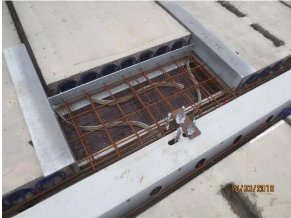
Abbildung 74: Baustelle BO - Stahlwechselkonstruktion für Hohlplatten, [ACMS Architekten GmbH], 16.03.2018
