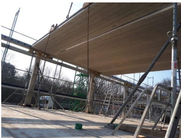
Abbildung 13: Baustelle BO - Elementdecke, [ACMS Architekten GmbH]
