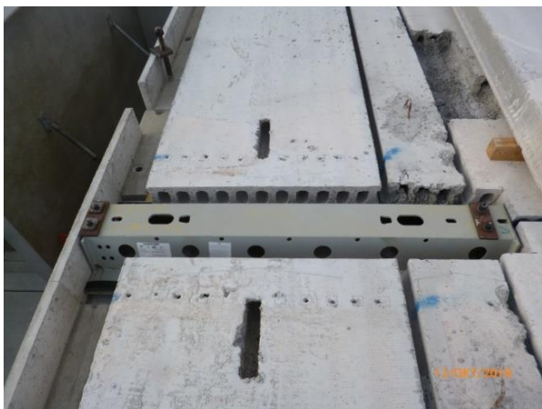
Abbildung 34: Foto Baustelle Stahlträger, [ACMS Architekten GmbH], 12.10.2018
