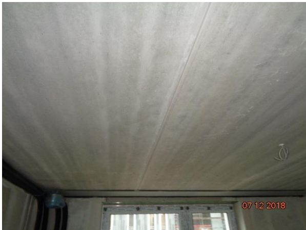
Abbildung 53: Baustelle BO - Deckenuntersicht nach der Nachbesserung der Plattenstöße Haus A, [ACMS Architekten GmbH], 07.12.2018
