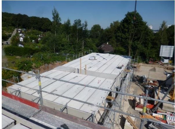
Abbildung 64: Baustelle BO - quer zur Spannrichtung liegende Schächte / Deckendurchbrüche, [ACMS Architekten GmbH], 29.06.2018 Abbildung 65: Baustelle WU - längs zur Spannrichtung liegende Schächte / Deckendurchbrüche, [ACMS Architekten GmbH], 28.06.2018
