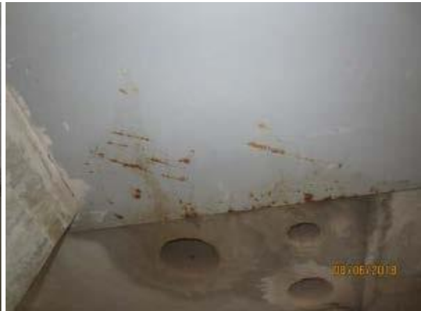
Abbildung 83: Baustelle BO - Rost an Verbundträger, [ACMS Architekten GmbH], 08.06.2018
