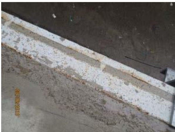
Abbildung 85: Baustelle BO - Rost an Verbundträger, [ACMS Architekten GmbH], 08.06.2018
