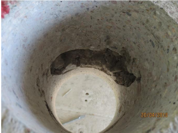
Abbildung 71: Baustelle BO - mangelhafter Betonverguss, [ACMS Architekten GmbH], 20.04.2018
