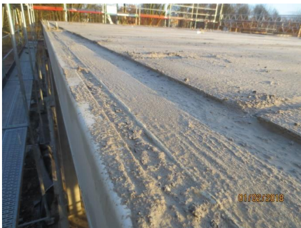
Abbildung 55: Baustelle BO - Ausführung des Anschlusspunktes Stahlverbundträger (Peikko) als Randträger und Spannbeton-Hohlplattendecke, [ACMS Architekten GmbH], 23.01.2018
