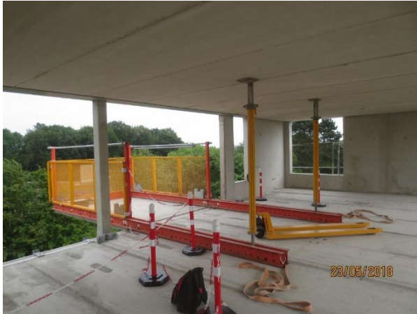
Abbildung 117: Baustelle BO - Einbringungsplattform Fertignasszellen, [ACMS Architekten GmbH], 23.05.2018
