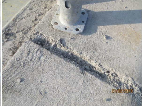
Abbildung 59: Baustelle BO - Ausführung des Anschlusspunktes Stahlbetonverbundträger (Peikko) als Mittelträger und Spannbeton-Hohlplattendecke, [ACMS Architekten GmbH], 21.02.2018
