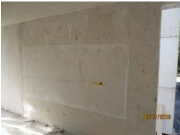
Abbildung 99: Baustelle BO - sichtbarer Lagerabdruck, [ACMS Architekten GmbH], 09.07.2018
