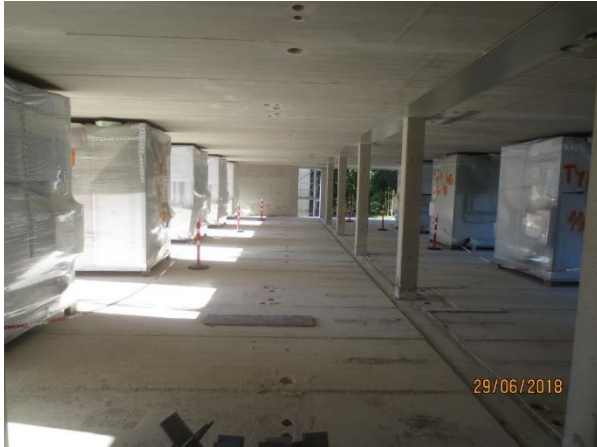
Abbildung 64: Baustelle BO - quer zur Spannrichtung liegende Schächte / Deckendurchbrüche, [ACMS Architekten GmbH], 29.06.2018 Abbildung 65: Baustelle WU - längs zur Spannrichtung liegende Schächte / Deckendurchbrüche, [ACMS Architekten GmbH], 28.06.2018
