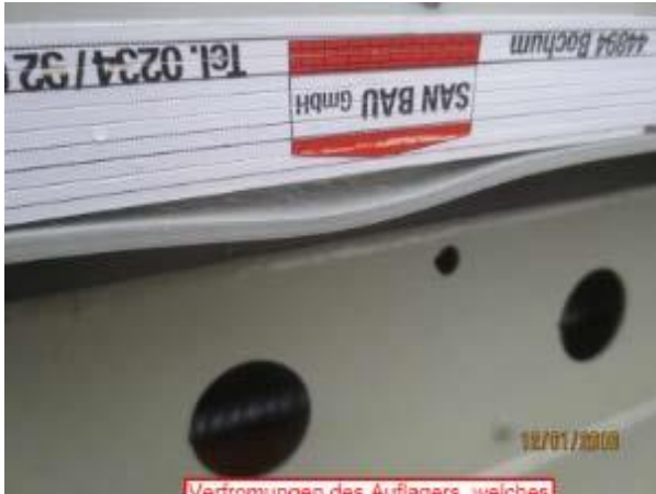
Abbildung 79: Baustelle BO - Verformungen am Auflager, [ACMS Architekten GmbH], 12.01.2018
