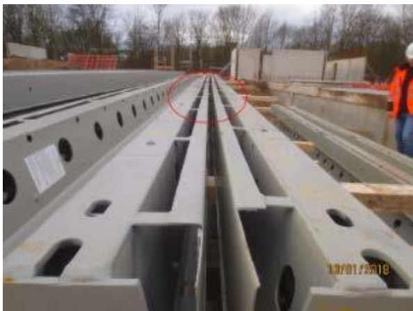
Abbildung 76: Baustelle BO - verbogene Träger, [ACMS Architekten GmbH], 10.01.2018
