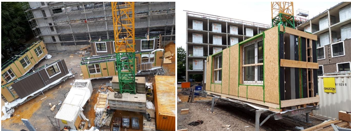
Abbildung 158: Baustelle BO - Transport der Holztafeln auf Transportbrücken, [ACMS Architekten GmbH]
