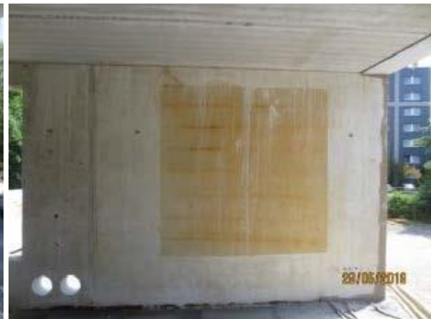
Abbildung 99: Baustelle BO - sichtbarer Lagerabdruck, [ACMS Architekten GmbH], 09.07.2018
