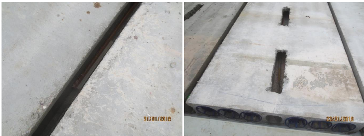
Abbildung 66: Baustelle BO - Bewehrungseinlage in der Fuge zwischen den Deckenplatten, [ACMS Architekten GmbH], 31.01.2018
