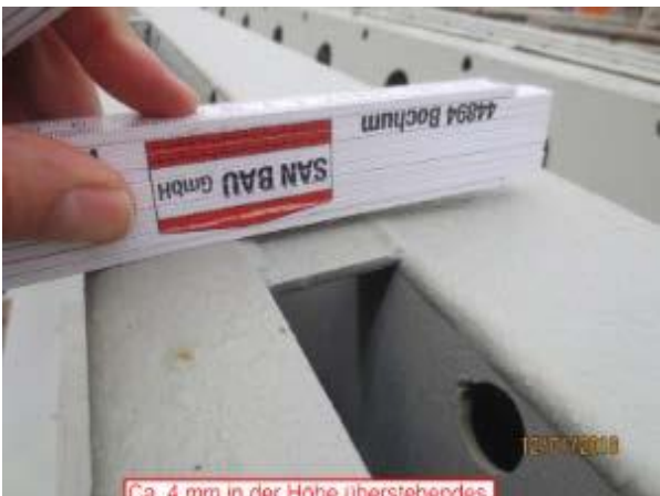
Abbildung 77: Baustelle BO - überstehendes Abschaltblech des Randträgers, [ACMS Architekten GmbH], 12.01.2018
