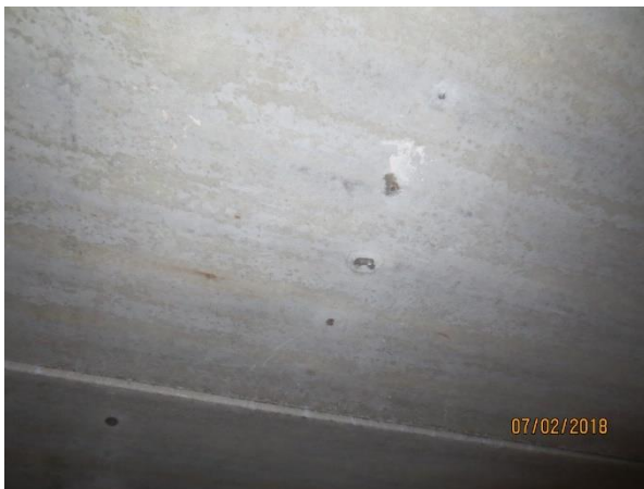
Abbildung 46: Baustelle BO - unregelmäßig ausgeführte Abstände der Entwässerungslöcher, [ACMS Architekten GmbH], 07.02.2018 Abbildung 47: Baustelle BO - Frostschaden (Abplatzungen an Hohlplattenunterseite) durch nicht ausgeführte Entwässerungslöcher, [ACMS Architekten GmbH], 21.03.2018
