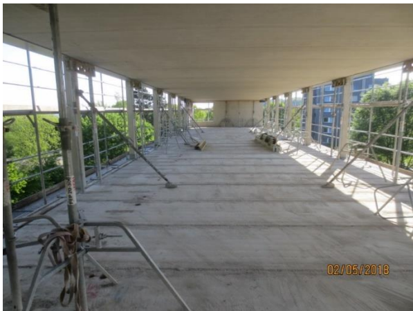
Abbildung 69: Baustelle BO - Abstützung der Spannbeton-Hohlplattendecke, [ACMS Architekten GmbH], 02.05.2018
