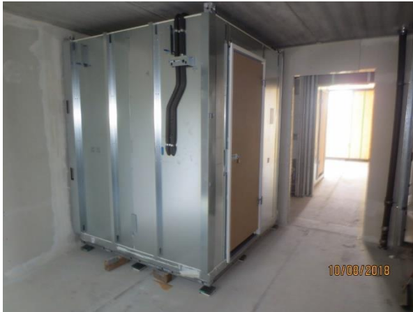
Abbildung 120: Baustelle BO - Platzierung der Fertignasszelle innen, [ACMS Architekten GmbH], 10.08.2018
