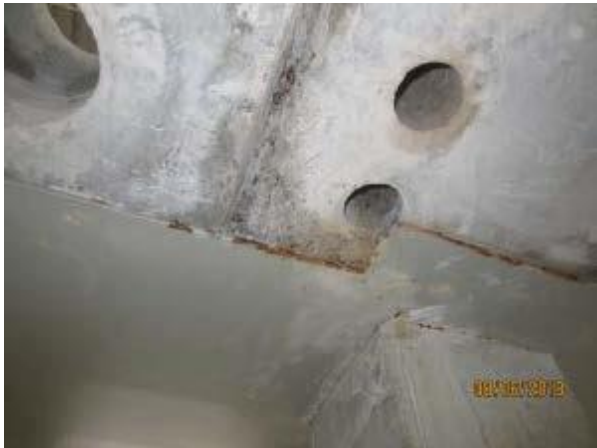
Abbildung 83: Baustelle BO - Rost an Verbundträger, [ACMS Architekten GmbH], 08.06.2018
