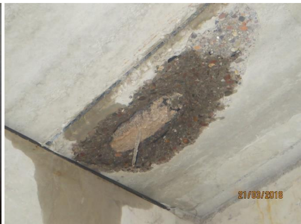
Abbildung 46: Baustelle BO - unregelmäßig ausgeführte Abstände der Entwässerungslöcher, [ACMS Architekten GmbH], 07.02.2018 Abbildung 47: Baustelle BO - Frostschaden (Abplatzungen an Hohlplattenunterseite) durch nicht ausgeführte Entwässerungslöcher, [ACMS Architekten GmbH], 21.03.2018
