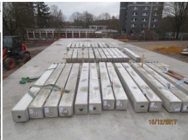
Abbildung 41: Baustelle BO - Stahlbeton-Fertigteilstützen 1.OG, [ACMS Architekten GmbH], 06.02.2018
