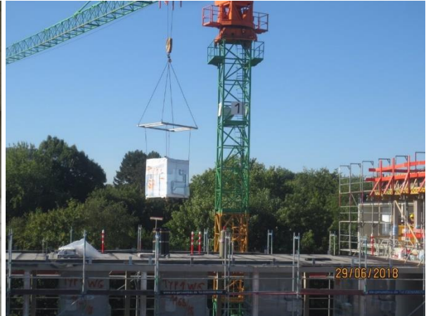
Abbildung 117: Baustelle BO - Einbringungsplattform Fertignasszellen, [ACMS Architekten GmbH], 23.05.2018
