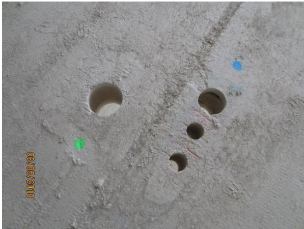
Abbildung 73: Baustelle BO - Sanierung, grün: spachteln, blau: Hohlkammer öffnen und vergießen, [ACMS Architekten GmbH], 03.05.2018
