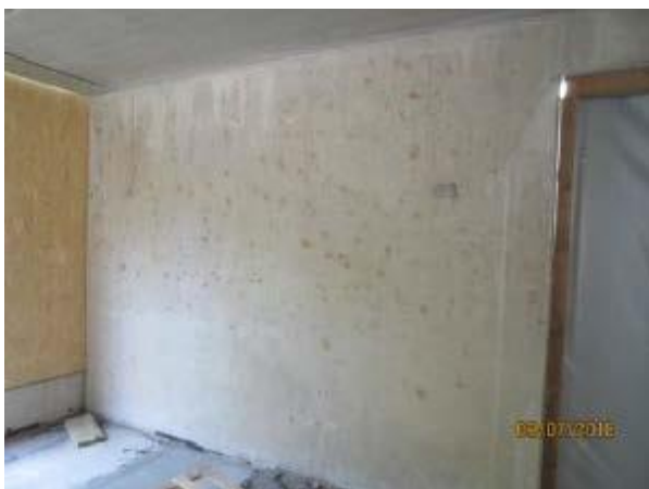
Abbildung 101: Baustelle BO - sichtbaren Ablagerungen, [ACMS Architekten GmbH], 09.07.2018
