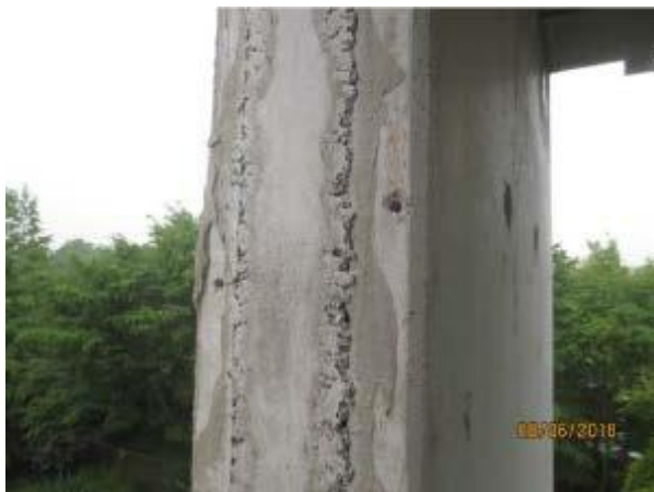
Abbildung 96: Baustelle BO - Laibungsfläche Halbfertigteilwand, [ACMS Architekten GmbH], 08.06.2018
