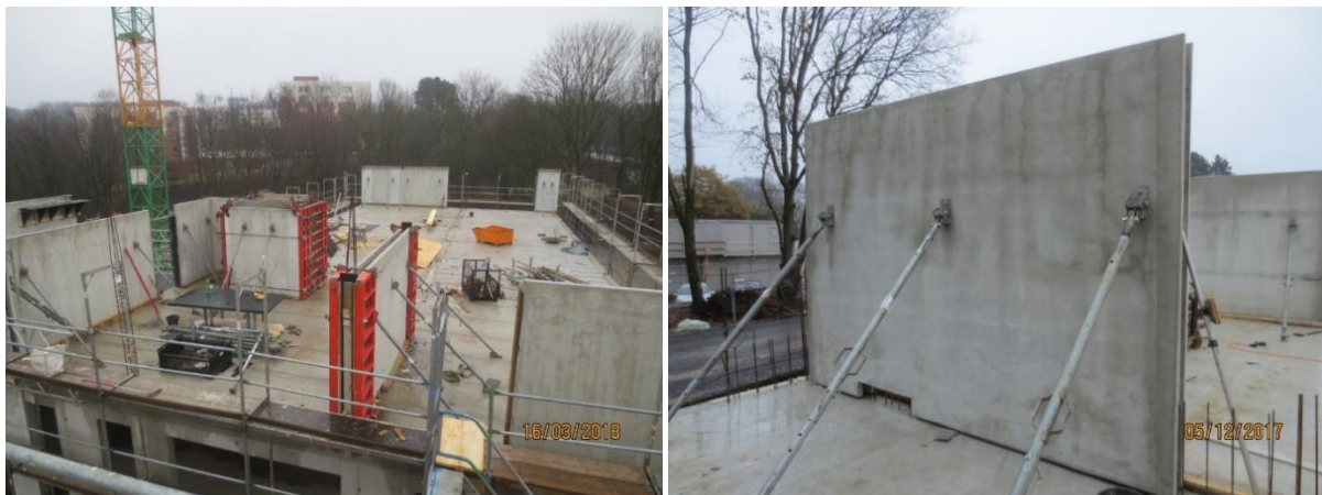
Abbildung 39: Baustelle BO - Elementwände Haus C1, [ACMS Architekten GmbH], 16.03.2018
