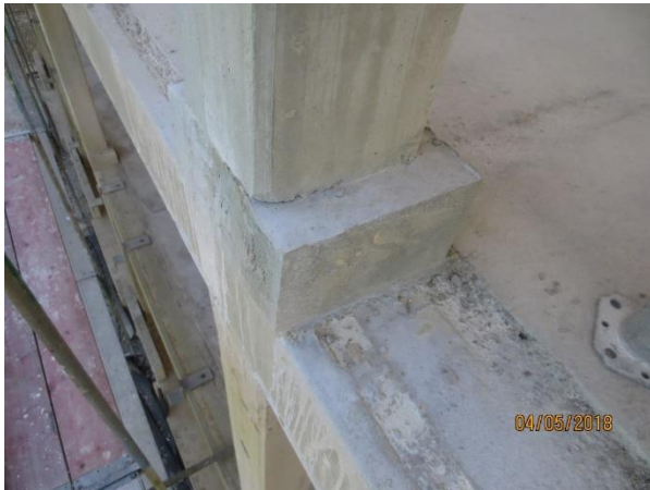
Abbildung 109: Baustelle BO - Stützenanschluss mit Mörtelkragen, [ACMS Architekten GmbH], 04.05.2018
