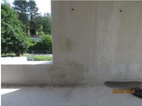
Abbildung 97: Baustelle BO - sichtbare Ausbesserungen, [ACMS Architekten GmbH], 28.05.2018
