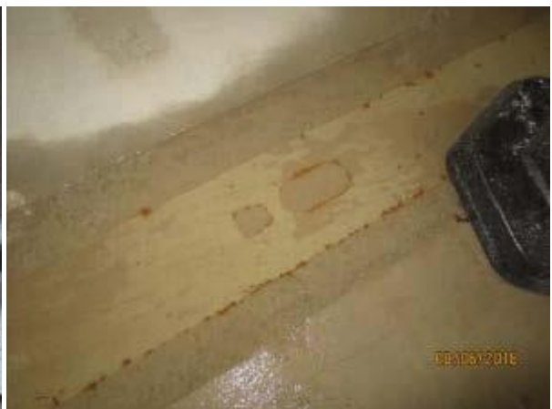
Abbildung 85: Baustelle BO - Rost an Verbundträger, [ACMS Architekten GmbH], 08.06.2018
