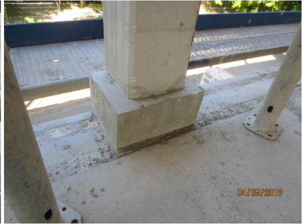
Abbildung 107: Baustelle BO - Stützenanschluss mit Mörtelkragen, [ACMS Architekten GmbH], 27.03.2018
