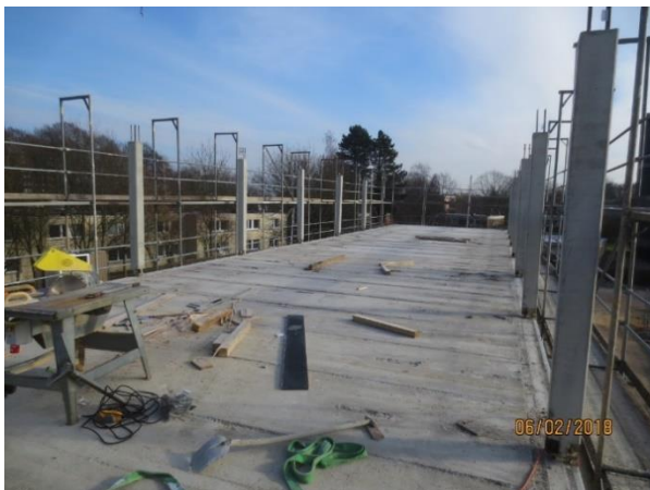
Abbildung 41: Baustelle BO - Stahlbeton-Fertigteilstützen 1.OG, [ACMS Architekten GmbH], 06.02.2018
