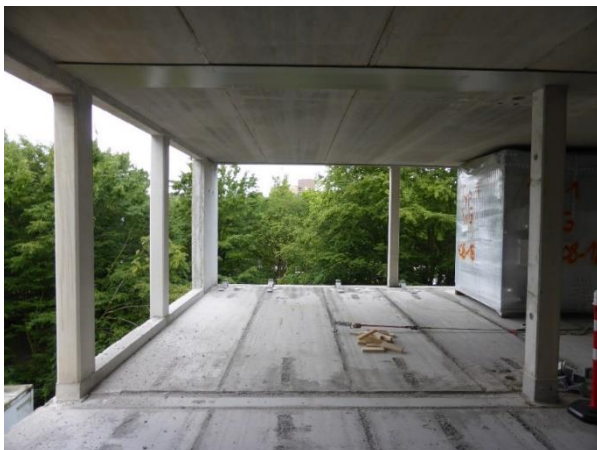
Abbildung 81: Baustelle BO - Deckenansicht Verbundträger, [ACMS Architekten GmbH]
