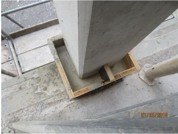
Abbildung 107: Baustelle BO - Stützenanschluss mit Mörtelkragen, [ACMS Architekten GmbH], 27.03.2018
