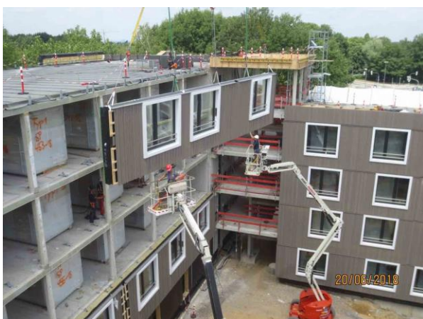
Abbildung 164: Baustelle BO - Montage der Holztafelelemente, [ACMS Architekten GmbH]
