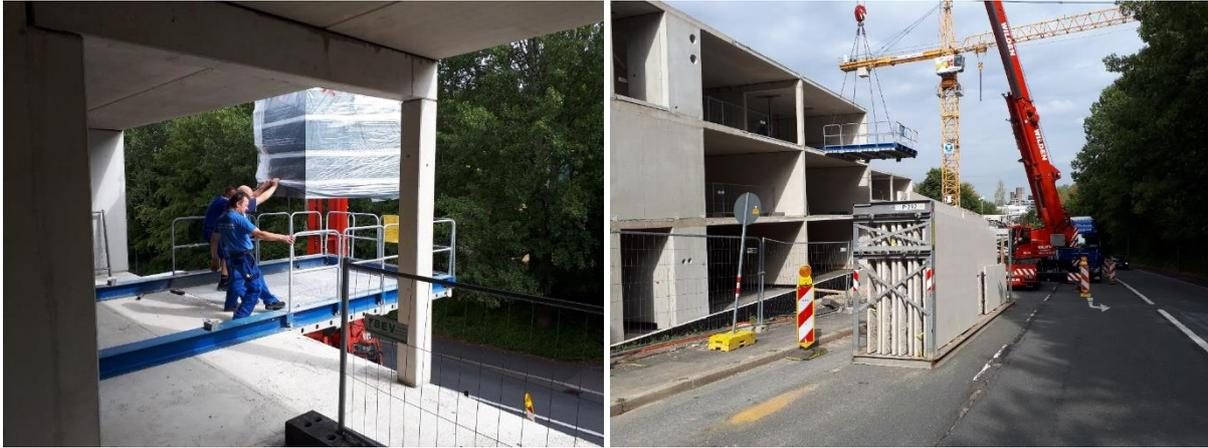
Abbildung 76: Baustelle WU - Einbringungsplattform Fertignasszellen, [ACMS Architekten GmbH], 21.08.2018
