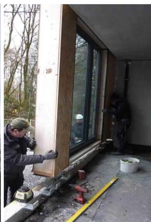
Abbildung 136: Baustelle WU - Montage der Holztafelelemente, [ACMS Architekten GmbH]
