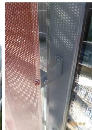
Abbildung 138: Baustelle WU - Befestigung der Fassadenbekleidung an Fenster, [ACMS Architekten GmbH], 02.09.2019
