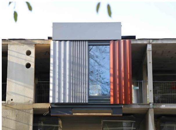
Abbildung 134: Baustelle WU - Musterfassade auf der Baustelle, [ACMS Architekten GmbH]
