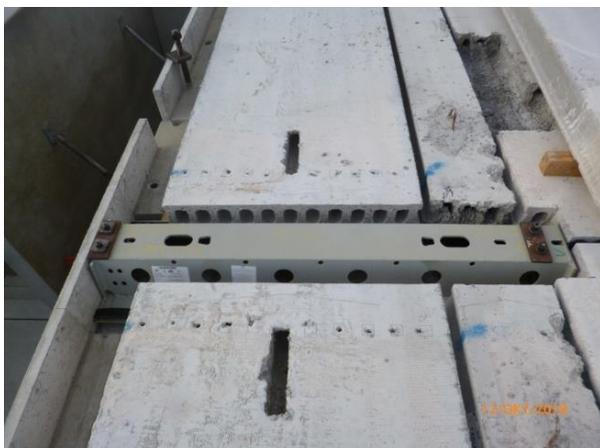
Abbildung 37: Foto Baustelle Wuppertal- Stahlträger, [ACMS Architekten GmbH], 12.10.2018
