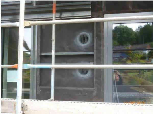
Abbildung 130: Baustelle WU - Lüftungsdurchführung in der Installationsebene, [ACMS Architekten GmbH]
