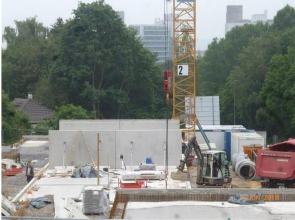
Abbildung 45: Baustelle WU - Stahlbeton-Fertigteilwand Haus 164, [ACMS Architekten GmbH], 05.06.2018
