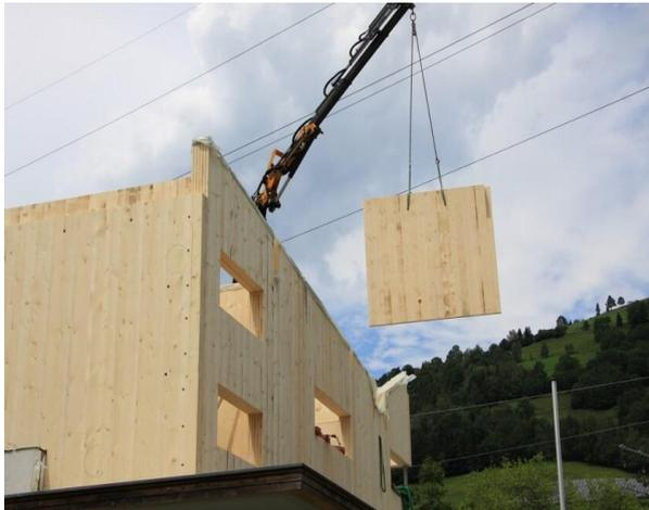
Abbildung 92: Massivholzbauweise, [Holz vom Fach]
