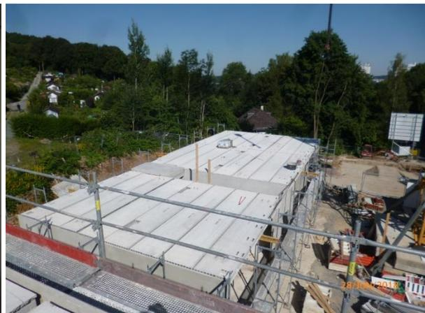
Abbildung 57: Baustelle BO - quer zur Spannrichtung liegende Schächte / Deckendurchbrüche, [ACMS Architekten GmbH], 29.06.2018
