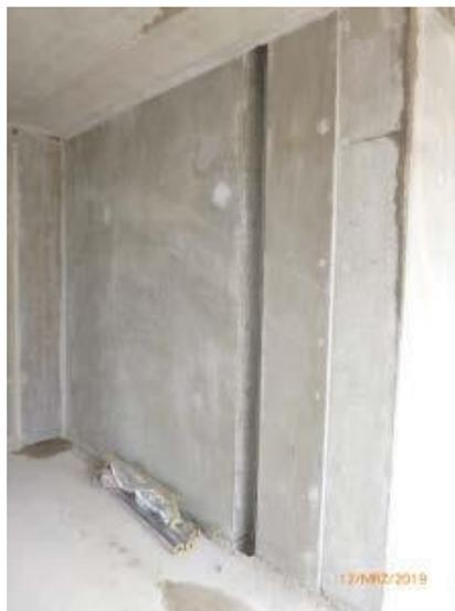
Abbildung 62: Baustelle WU - Montageaussparung in Fertigwand für Anschluss Verbundträger, [ACMS Architekten GmbH], 12.03.2019
