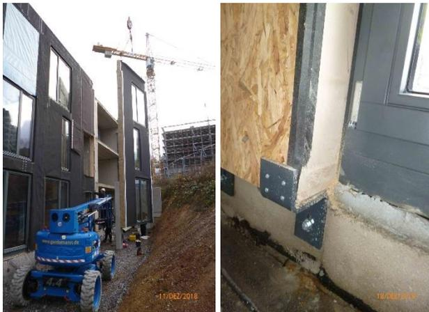
Abbildung 139: Baustelle WU - Montage der Holztafelelemente, [ACMS Architekten GmbH]
