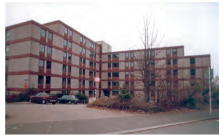
(2) Die Bestandsanlage erschien abweisend. Sie wurde zudem zum sozialen Brennpunkt.
