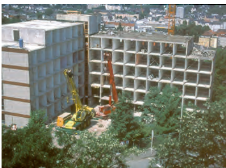
(8) Im ersten Schritt wurde das Gebäude vollständig entkernt.
