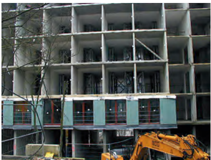
(9) Hochwärmegedämmten Fassadenelemente wurden vor den Rohbau gehängt.
