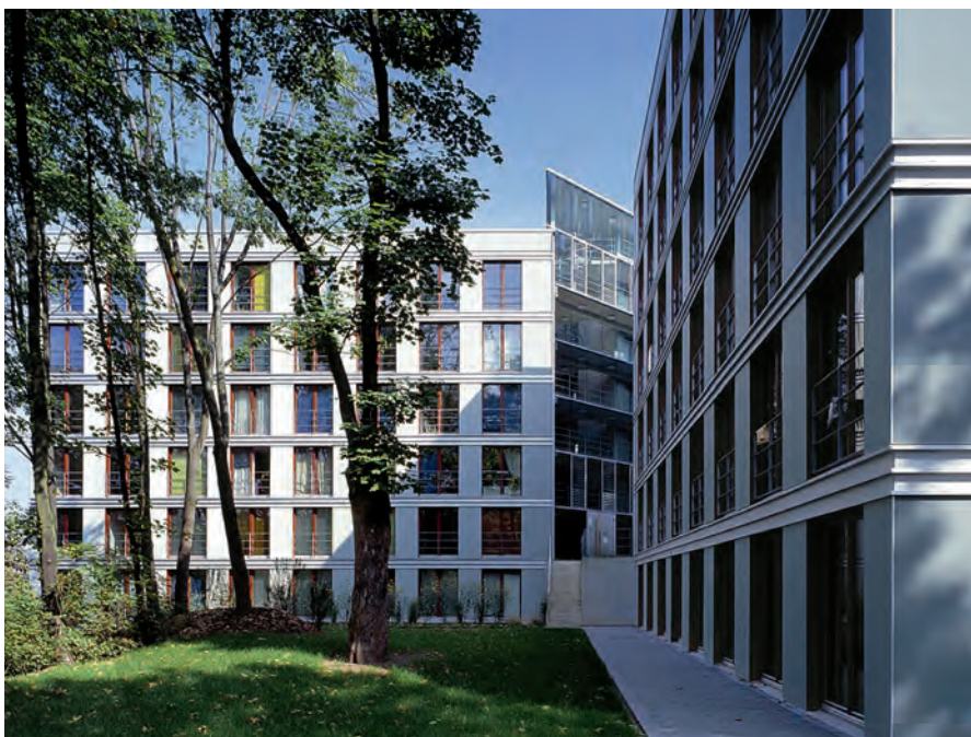
(12) Die im Passivhausstandard gedämmten Bauteile staffeln sich in kompakter Bauweise um den zentralen Platz und die beiden ungedämmten Trepphaustürme.
