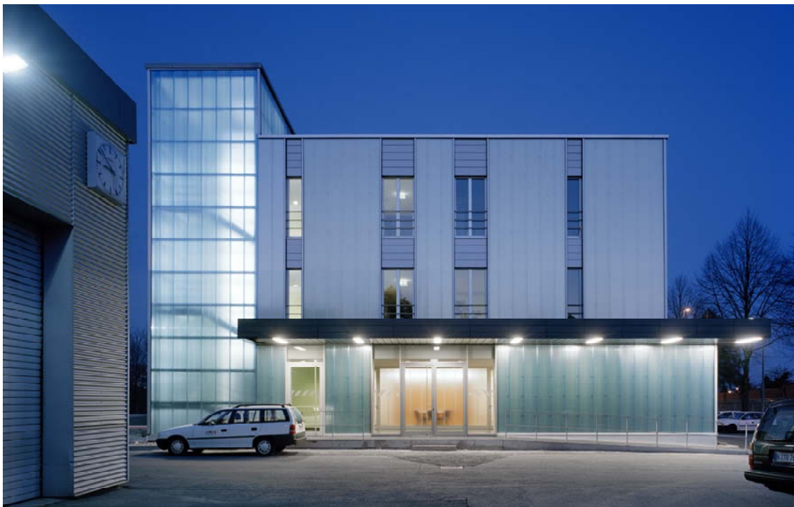
Abbildung 27: West- Ansicht Haupteingang nach der Sanierung
