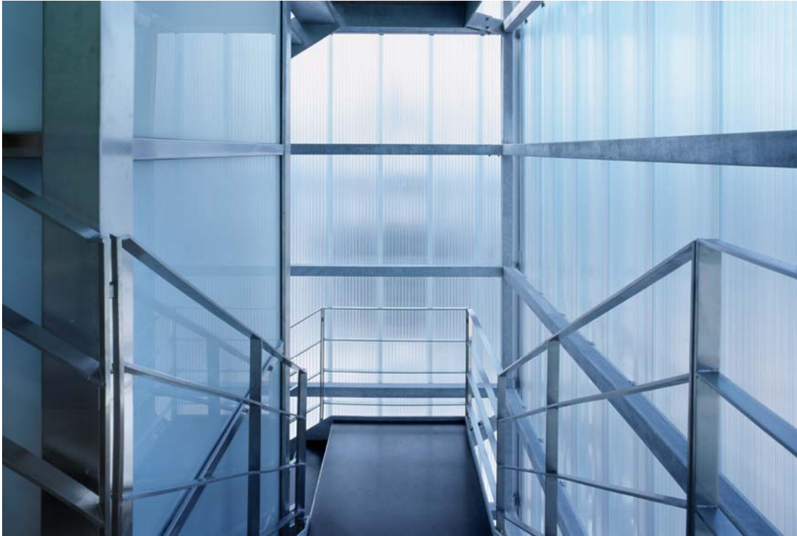
Abbildung 26: Innenansicht Treppenhaus nach der Sanierung
