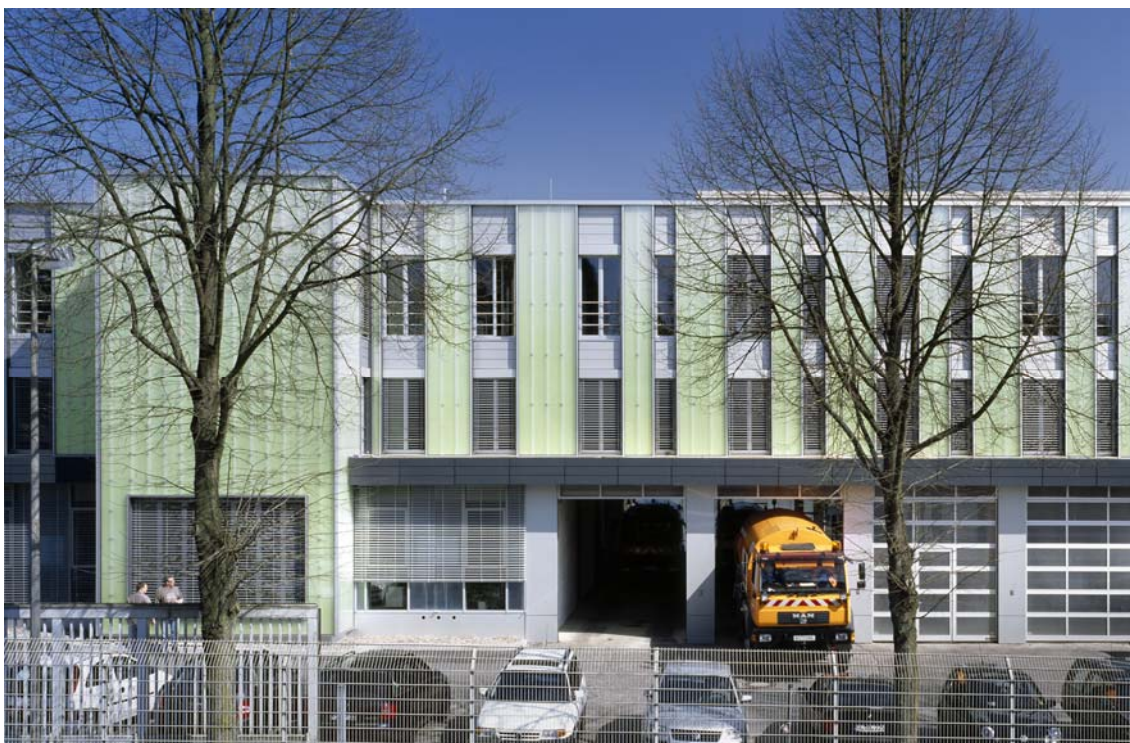
Abbildung 24: Nord- Ansicht Wagenhalle nach der Sanierung
