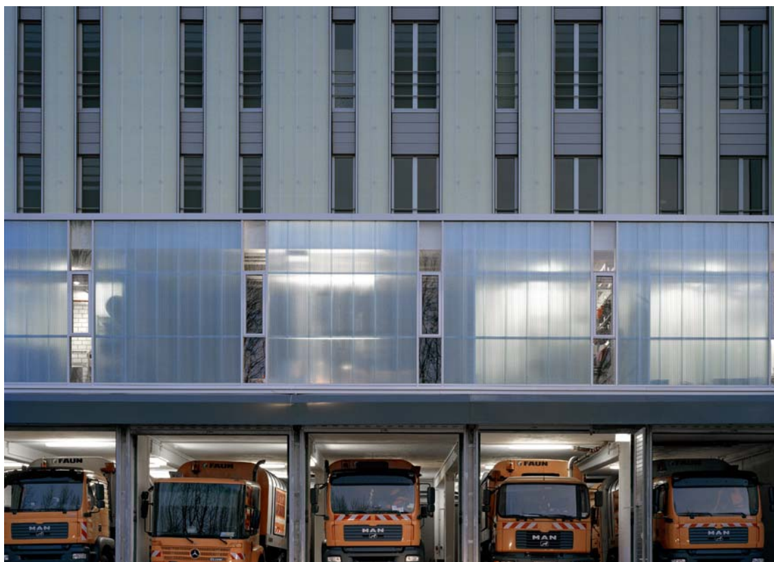
Abbildung 25: Süd- Ansicht Wagenhalle nach der Sanierung
